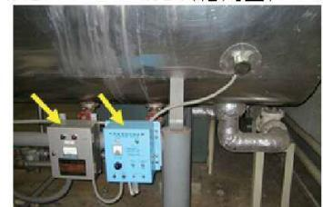
外部電源式電気防食装置(貯湯槽の外部に設置)
