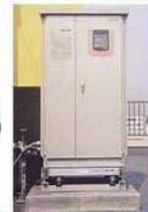
膜脱気法による水道水の脱酸素装置
