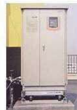
まくたつき ほうろ 膜脱気法による水道水 の脱酸素装置
