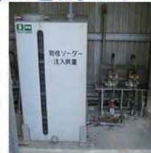
すいさん か ちゅうにゅうそうち 水酸化ナトリウム注入装置
